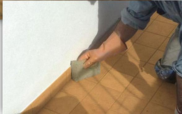
Dopo aver pulito e ripristinato le parti in cattivo stato della pavimentazione (se necessario), e dopo aver atteso l'asciugatura dello stucco e del sigil-lante, **versare e spandere PROTECH BALCONY su tutta la superficie da impermeabilizzare** (consumo indicativo 7-15 m<sup>2</sup>/litro a seconda del supporto).
